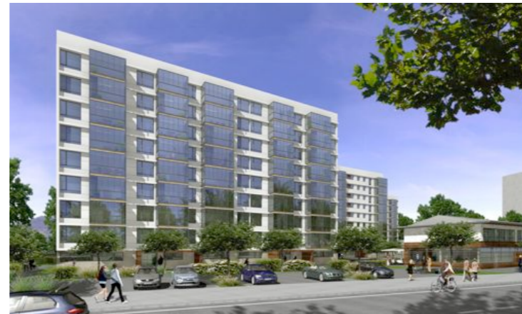
Wohnen und Gemeinschaftshaus Nord-Westansicht
